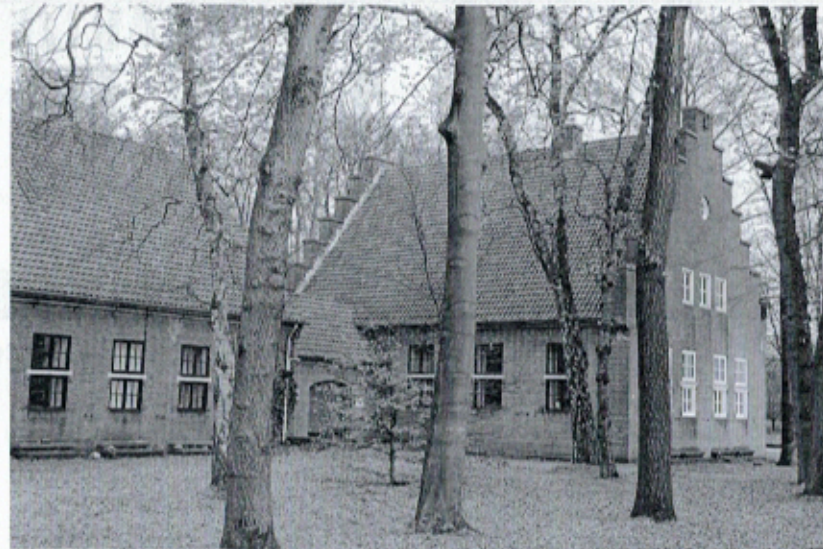
Voormalige officiersmess, nu ADT gebouw
